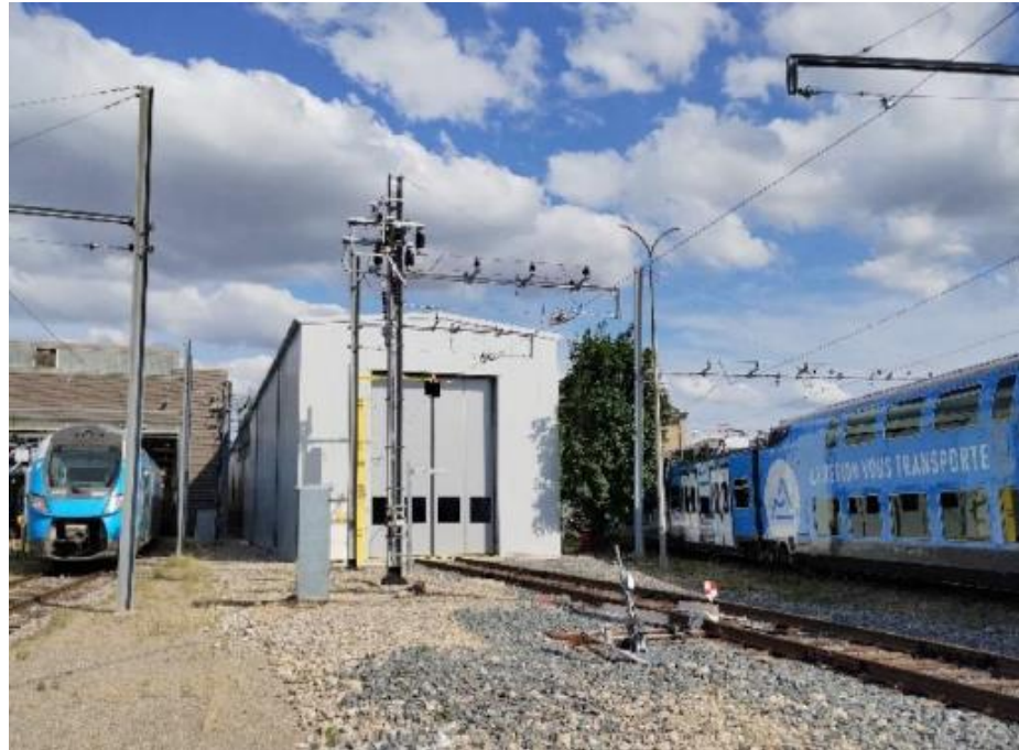
Vénissieux - bâtiment léger voie 11
