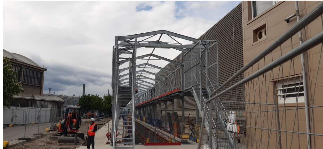
Travaux de couverture voie fosse-passerelle Vénissieux
