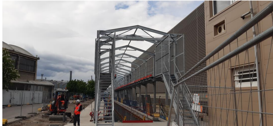
Travaux de couverture voie fosse-passerelle Vénissieux
