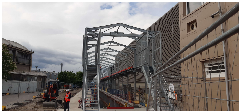
Travaux de couverture voie fosse-passerelle Vénissieux
